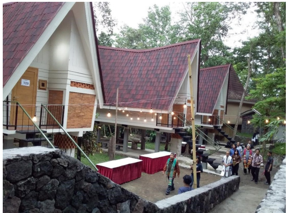
Wajah baru gedung yang direnovasi
